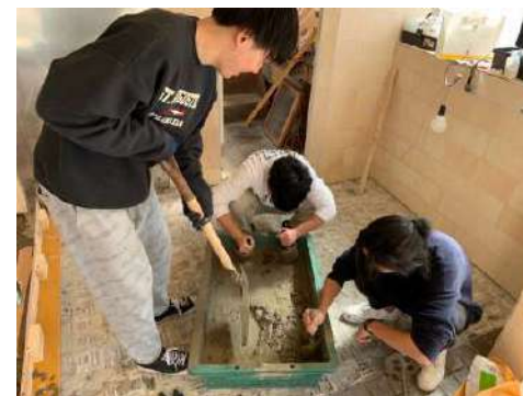
コンクリート打設
