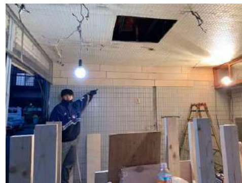
壁面 & 天井仕上げ貼り付け
