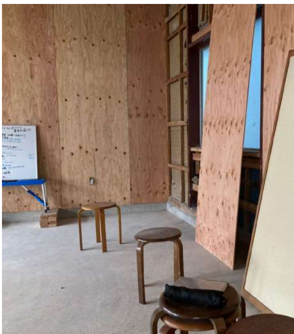
構造用合板によって壁を補強
