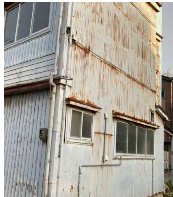
外壁の仕上げ材はトタン
