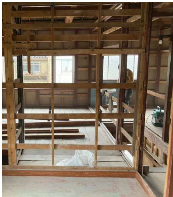
構造は貫によるラーメン構造
